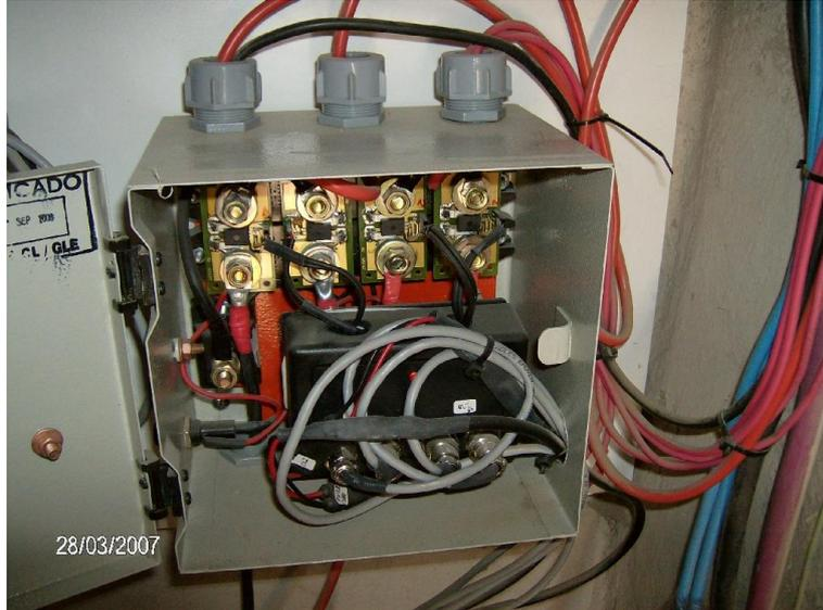
**Figura 6.38** Cuatro Sensores Allegro ACS750/52 de 50 y 100A del PWRC/12 y DL/2, y abajo amplificadores y LPF en equipo PERMER/Chubut de Costa de Ñorquinco (2007).
