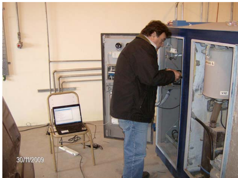
Figura 2 – Ing. Cappanera realizando conexión del equipo.
